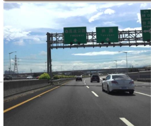
國道二號直通桃園國際機場
